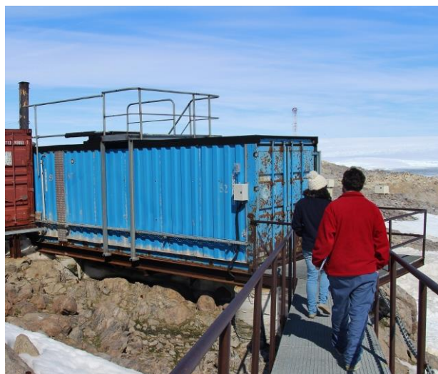
Le shelter LIDAR à DDU
