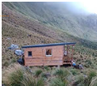
Capacité d'Entrecasteaux de 6 personnes avec énergie photovoltaïque et récupération d'eau de pluie
