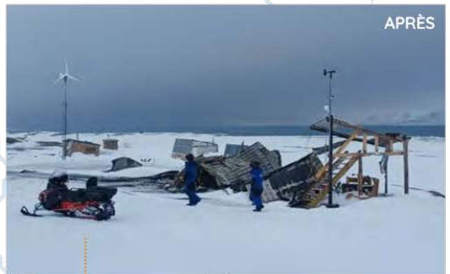
Le bâtiment D de Corbel avant et après l'incendie
