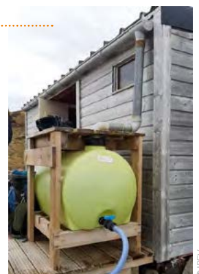
Cuve de récupération eau de pluie
