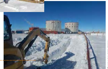
Enfouissement des lignes électriques
