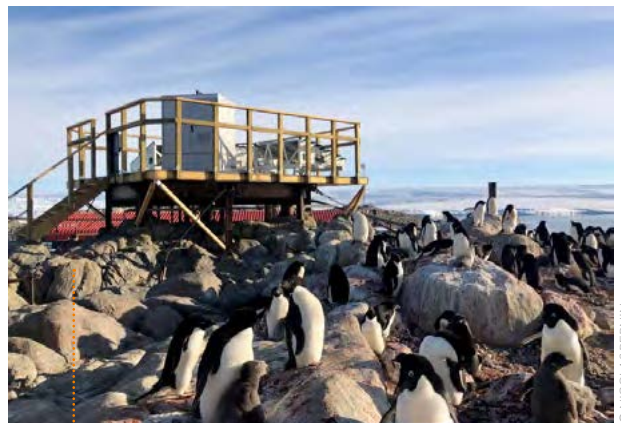
Plateforme équipée du profileur de vent du projet AWACA
